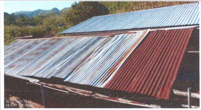
Foto 4: Cambio cubierta lamina estructura metalica en cocina.
