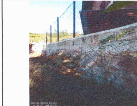
Foto 2: Culminación de creco perimetral
