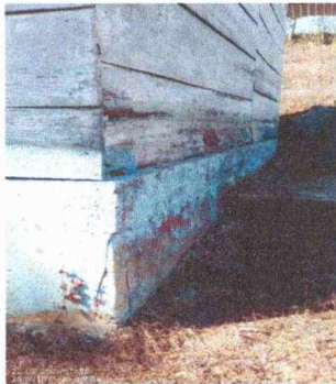
Foto 3: Culminación de paredes de cocina
